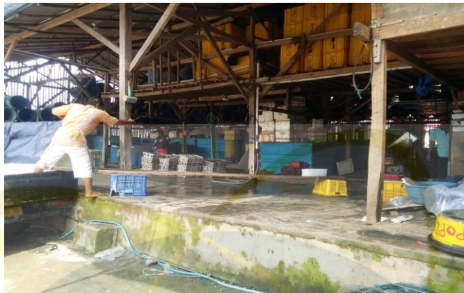
Gambar 2. 3 Gudang Penyimpanan Ikan Desa Sotabar (Foto: Dokumen Penulis)
